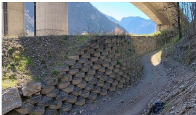
Exemple de merlon réalisé en « pneusol »
