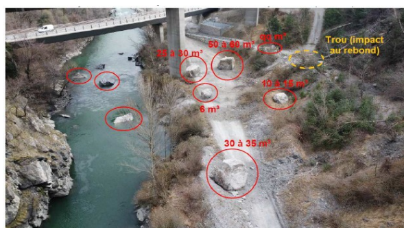
Relevés des blocs éboulés sur la route communale et dans l'Isère (ONF-RTM – 18/03/2022)
